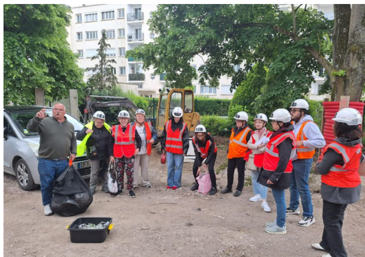
Les animateurs de Victor Hugo en visite sur le chantier.
