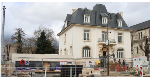
Travaux Hôtel de Ville
