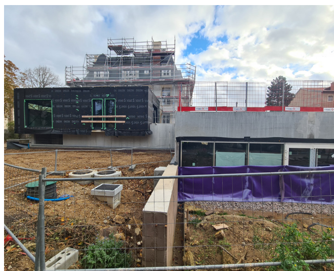
Vue depuis le parc, situé derrière le bâtiment
