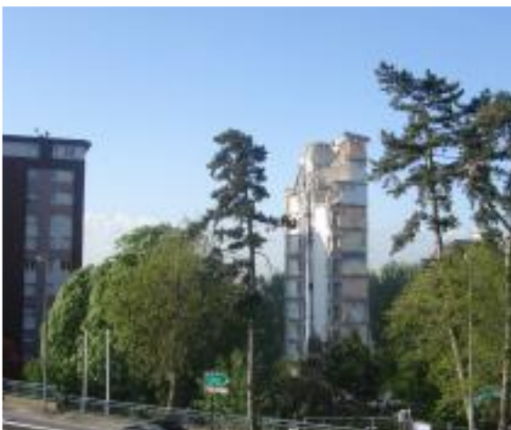
La démolition de l'immeuble Charcot début 2008
