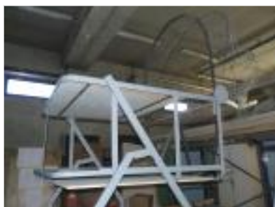
Une partie de la structure métallique
